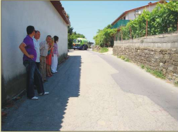
nadaljevanje rekonstrukcije ceste za Hrvatine proseguimento della ricostruzione della strada di Crevatini
